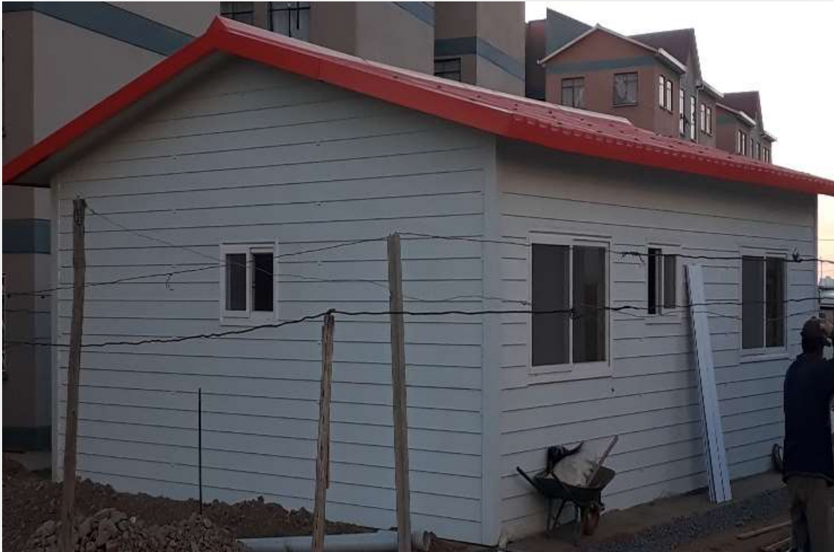
figura 1. Prototipo de Vivienda con Panel Sándwich EPS. Fuente: Agencia Estatal de Vivienda.
