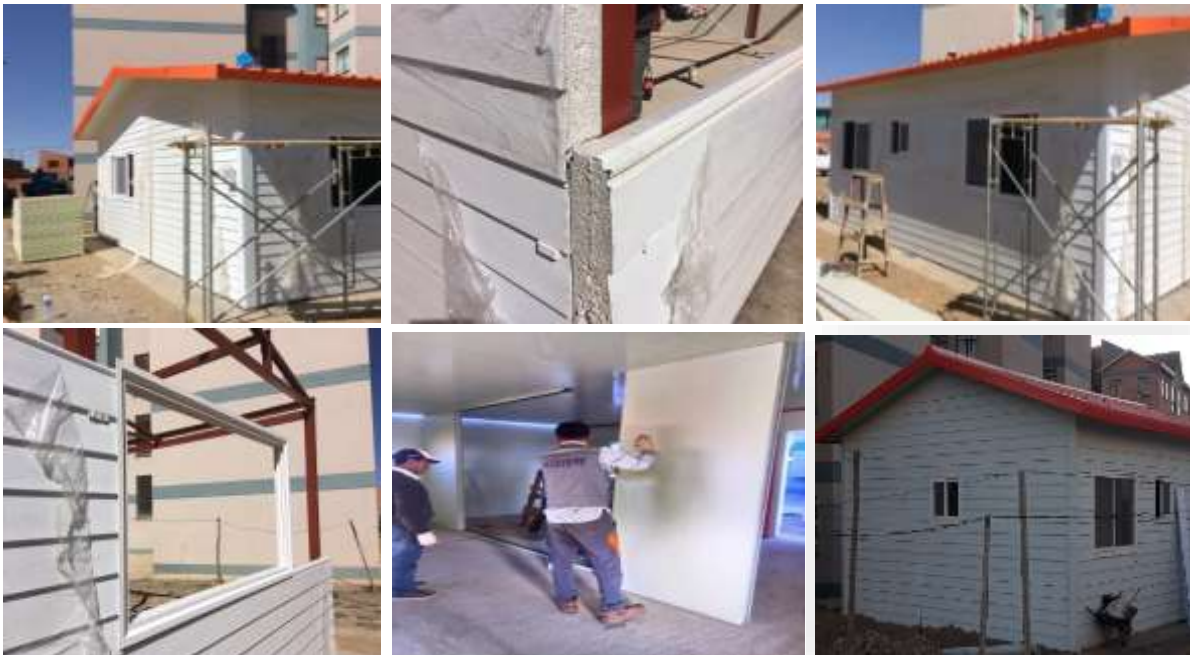
figura 2. Fotografías del prototipo con tecnología de Panel Sándwich. Fuente: AEVIENDA
